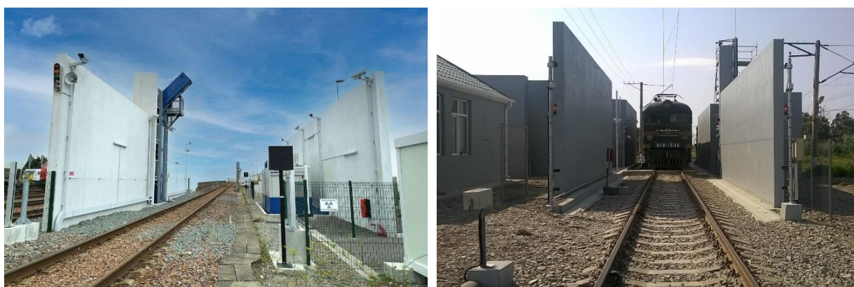
Slika 2.13. Primeri dva postrojenja za rendgensko skeniranje vozova
